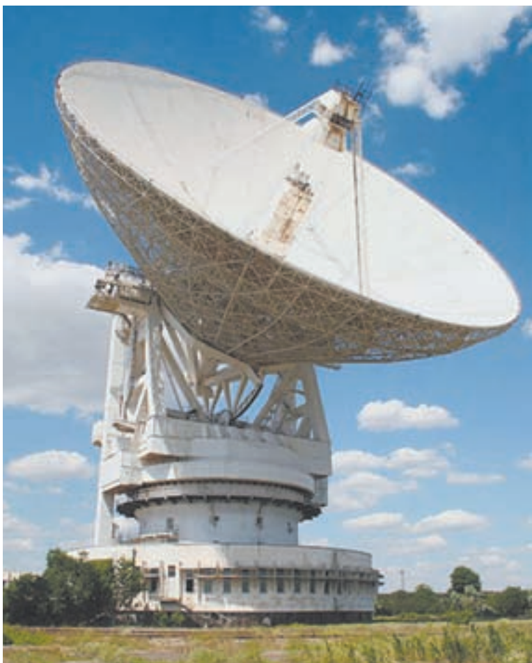
● Радиотелескоп П-2500 (РТ 70) – уникальный советский радиотелескоп с диаметром зеркала 70 м. Он способен улавливать сигналы космических аппаратов, находящихся на краю Солнечной системы.
