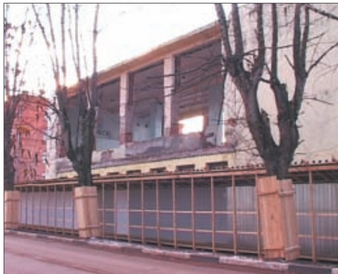
● Корпус «Олимпа» в стадии ремонта.
